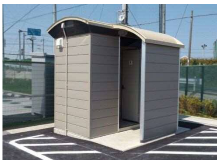
多目的グラウンド トイレ
